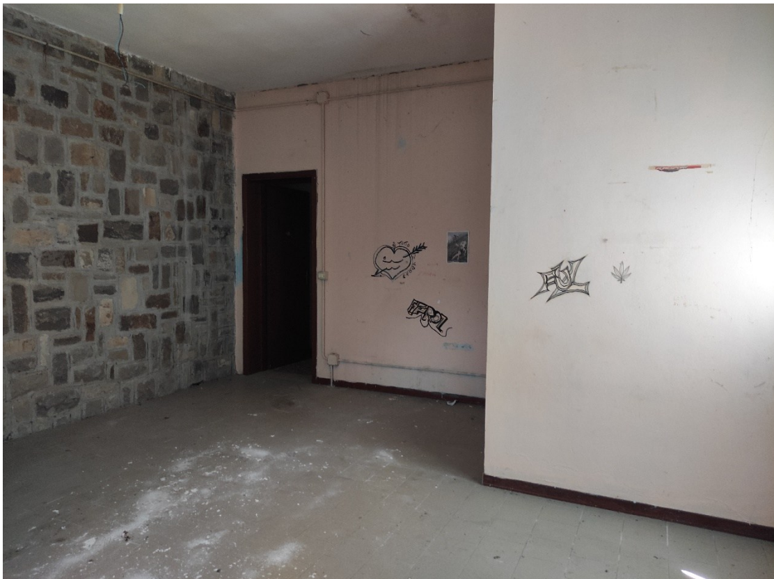
Fotografia n. 7: camera piano terra
