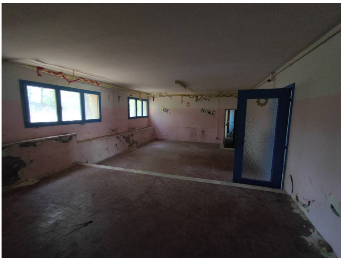
Fotografia n. 9: ripostiglio piano seminterrato
