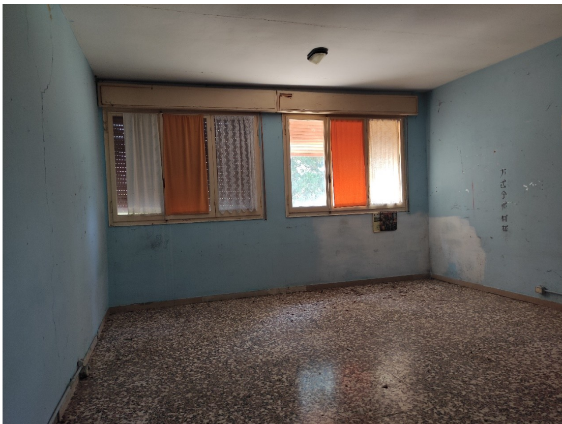
Fotografia n. 8: camera piano terra
