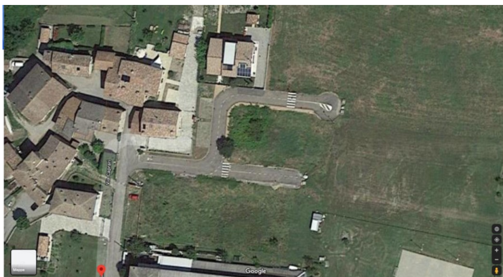
Particolare delle opere di urbanizzazione realizzate
