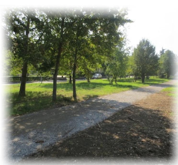
L'intervento, su progetto dello Studio Cervi in collaborazione con l'Ufficio Tecnico Comunale, prevede la realizzazione di un percorso ciclopedonale, della lunghezza di oltre un chilometro, comprensivo di sottofondo e pavimentazioni in calcestruzzo e triplo-strato.
